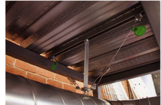
Longitudinal Bracing
